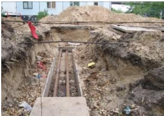
Заміна старих водопровідних труб
